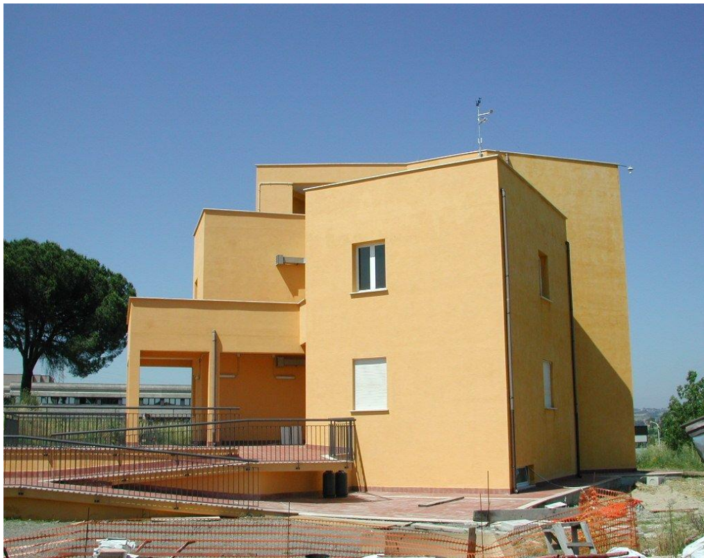
Edificio laboratorio Casa Intelligente realizzato nel Centro Ricerche ENEA-Casaccia, dalla Divisione Sistemi Energetici per la Mobilità e l'Habitat.
