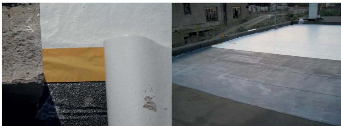
**Figura 5: Sovrapposizione della membrana alla striscia di biadesivo**
