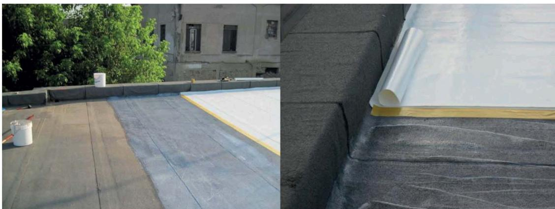
**Figura 4: Stesura del biadesivo sulla membrana**
