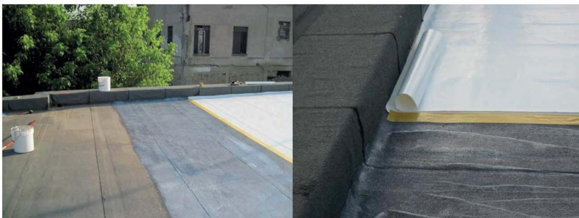
**Figura 4: Stesura del biadesivo sulla membrana**
