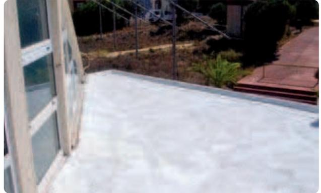
Figura 10. La copertura dopo l'applicazione del Cool Roof
