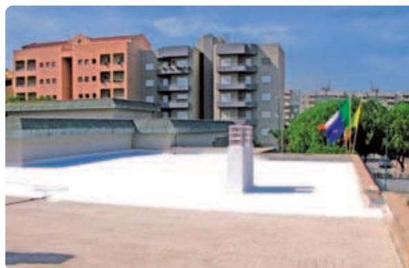
Figure 14. Vue du toit avec une application partielle de la peinture froide
